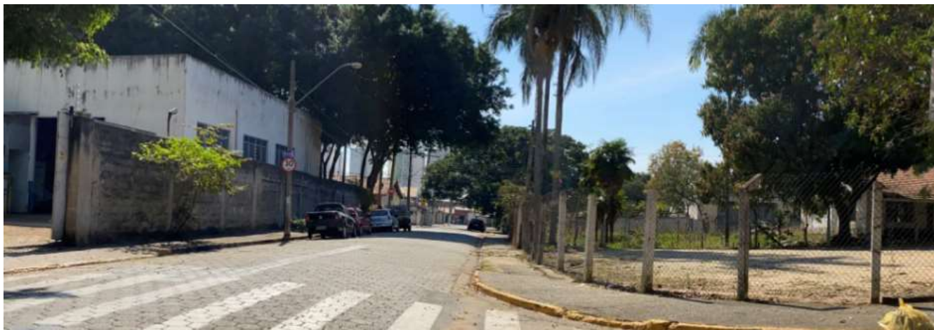
Figura 92 – Vista panorâmica do início do trecho em seção de contorno fechado, na Rua Irajá
