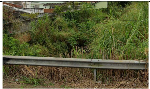
Figura 58 - Trecho sem revestimento
