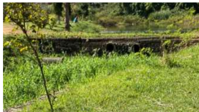
Figura 82- Extravisor lago existente a montante
