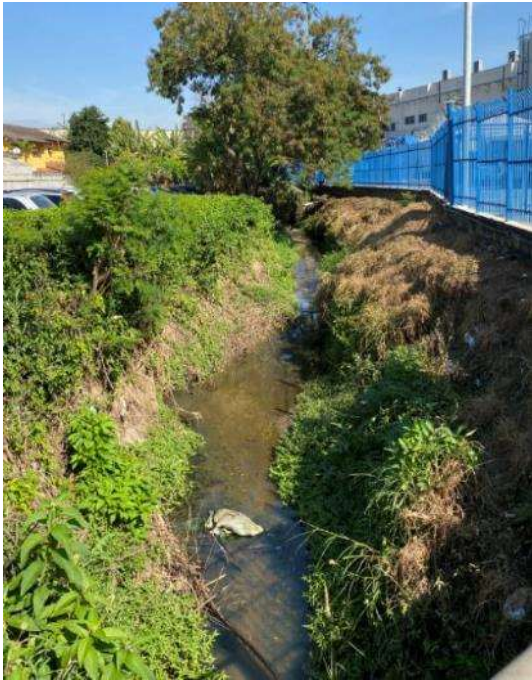
Figura 90 – Vista de montante da travessia
