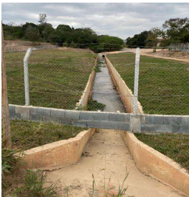
Figura 37 – Canal a montante da travessia
