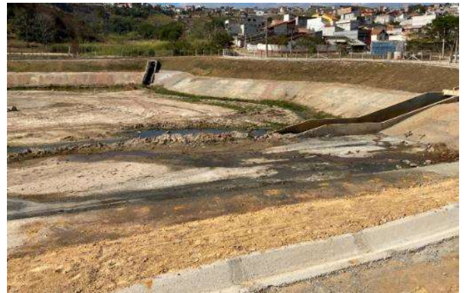
Figura 35 – Lançamento na Margem direita
