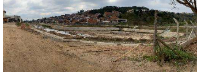
Figura 40 – Vista geral do reservatório
