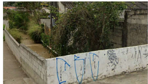
Figura 42 – Vista do trecho canalizado
