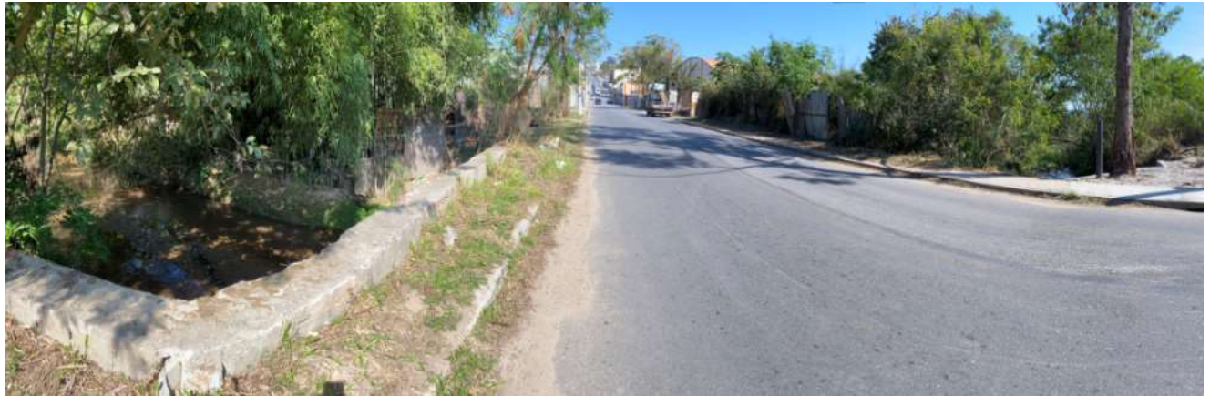
Figura 12 – Vista panorâmica da travessia
