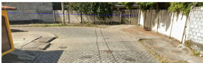
Figura 93 – Passagem sob a Rua Guaporé
