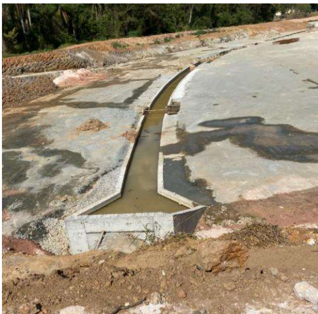
Figura 34 – Canal no talvegue da bacia de retenção
