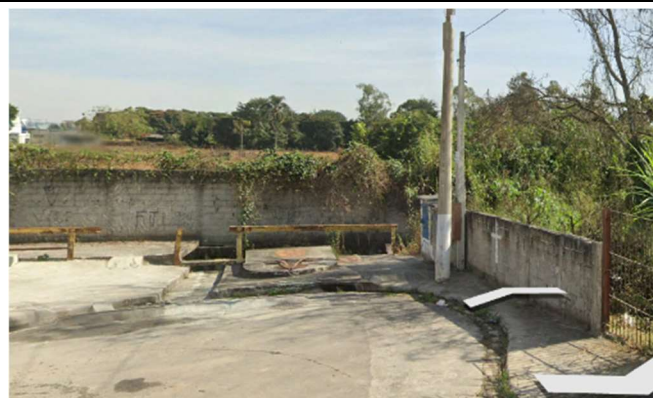
Figura 94- Passagem sob a Rua Moacir Coimbra (final do trecho canalizado)
