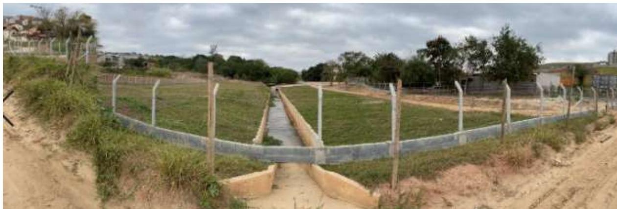
Figura 36 – Vista panorâmica a montante da travessia
