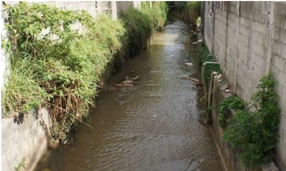
Figura 67 - Trecho em que o Rio Turi corre confinado entre muros de divisa de terrenos, sem acesso para manutenção
