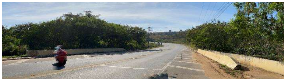
Figura 9 – Vista panorâmica da travessia
