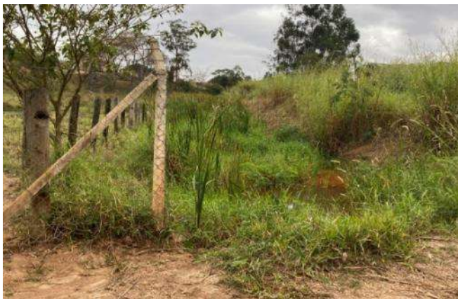
Figura 25 – Área alagada a jusante
