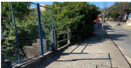
Figura 89 – Vista do parapeito da travessia
