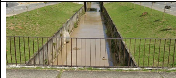
Figura 49 – Travessia na Rotatória do Pq. da Cidade e trecho canalizado
