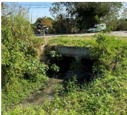
Figura 99 – Vista de montante da travessia
