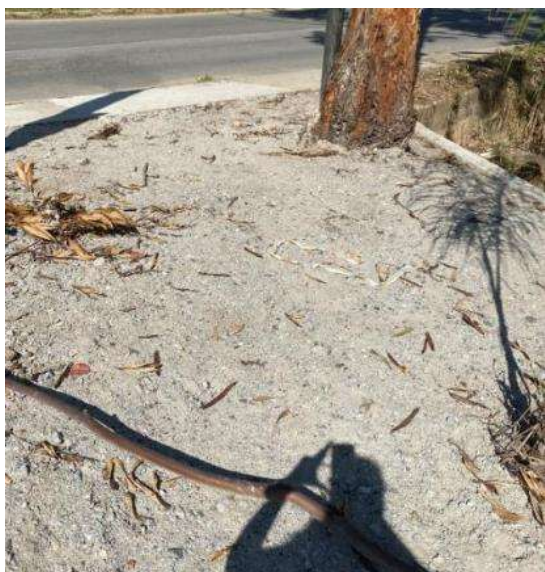
Figura 15 – Reaterro na aba
