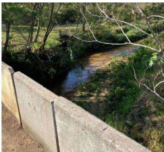
Figura 10 - Vista da travessia a montante
