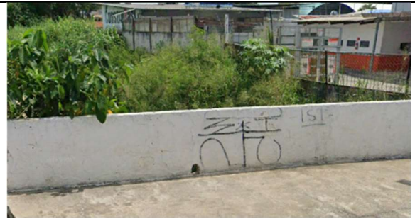
Figura 56 - Trecho sem revestimento
