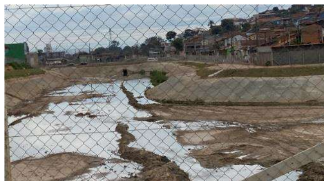
Figura 38 – Reservatório a jusante da travessia
