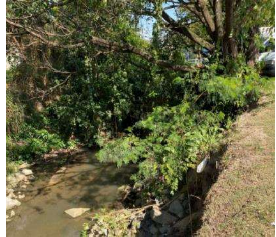
Figura 91- Vista de jusante para a travessia
